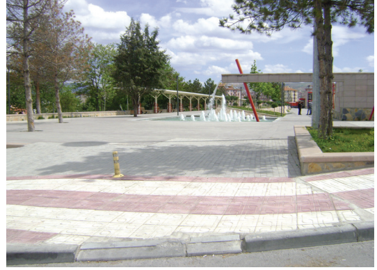
Şekil 5. Bosna Parkı D girişi önü kaldırım rampası
