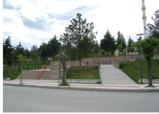
Şekil 8. Bosna Parkı G girişi rampa eğimi
